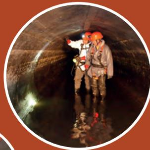
Die Mitarbeiter im Kanalunterhalt der Kommunalbetriebe kümmern sich ständig um das Ingolstädter Kanalnetz. Sie prüfen, ob noch alles in Ordnung ist und reinigen auch die Rohre und Abflussschächte. Dabei müssen sie auch in die Kanalisation einsteigen. In kleine Rohre lassen sie eine Spezialkamera fahren. Die Kontrolle ist wichtig, denn Schäden müssen repariert und Ablagerungen entfernt werden. Sonst kann es passieren, dass das Abwasser nicht weiterfließt und der Kanal überläuft.
